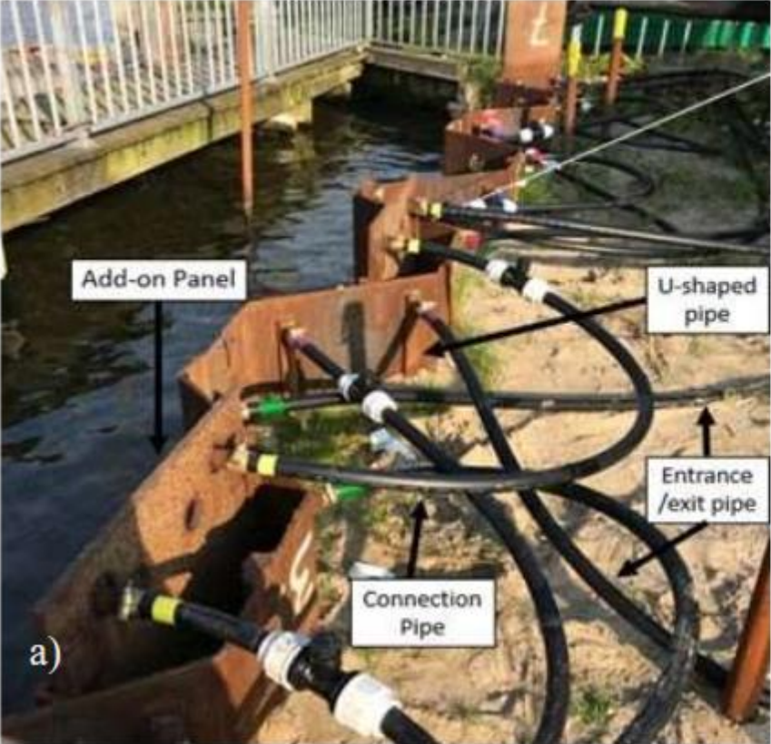
A-Palancola termoattiva con gli scambiatori di calore b) Loop superficiali e profondi installati con la palancola termoattiva (Gerola M., Cecinato F., Haasnoot J.K., Vardon P.J. 2022)
