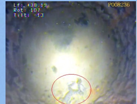
Ammaloramento del filtro
