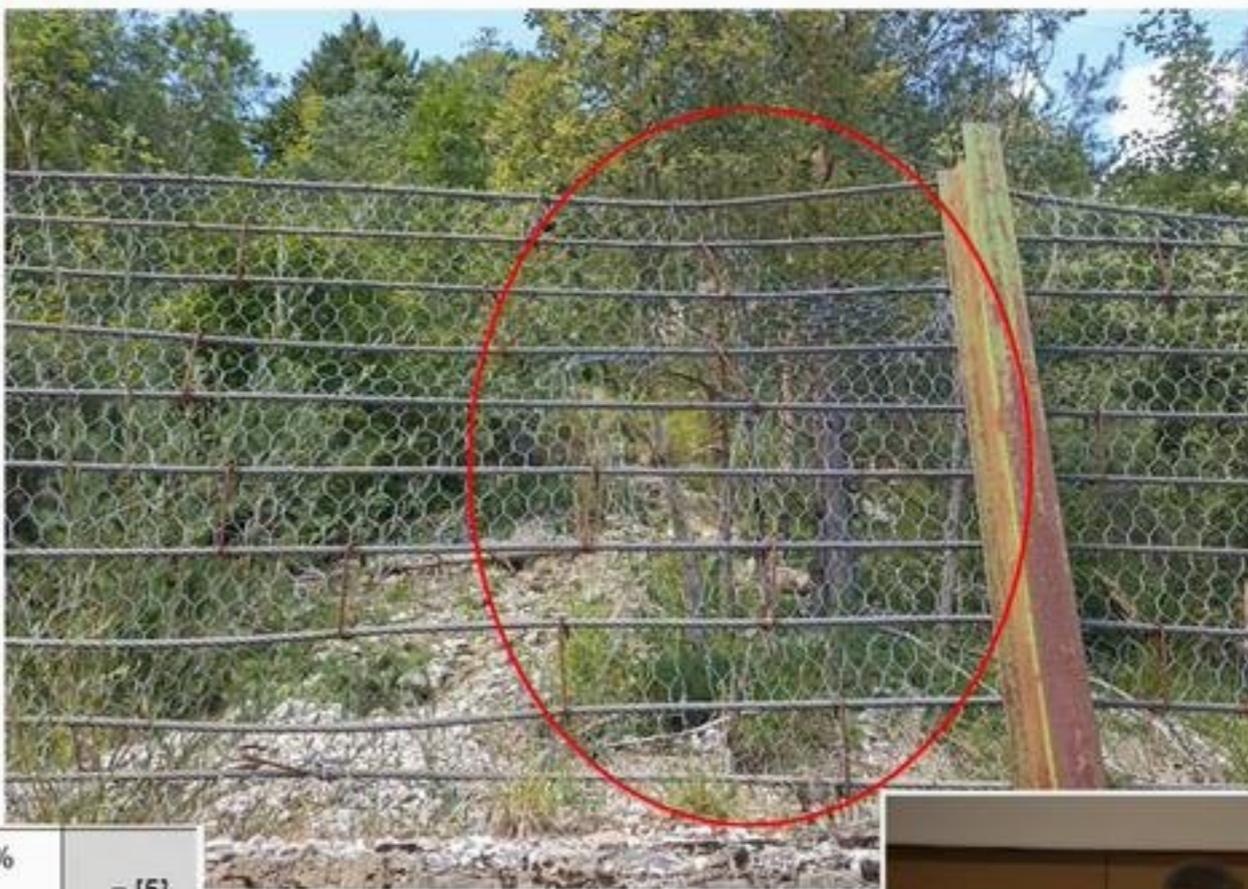
Presenza di materiale e massi nella struttura di intercettazione per altezza inferiore al 30% dell'altezza iniziale e/o forte ossidazione/corrosione, che possono compromettere l'efficienza dell'opera
